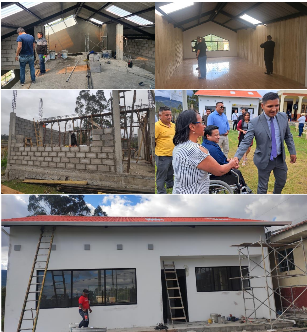
Foto 11: Re adecuación de la casa comunal de Adobepamba. Agosto 2023.
