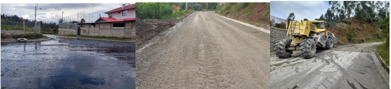
Foto 36: Tratamiento de doble riego en la vía San Vicente - Cristo del Consuelo. Mayo 2023
