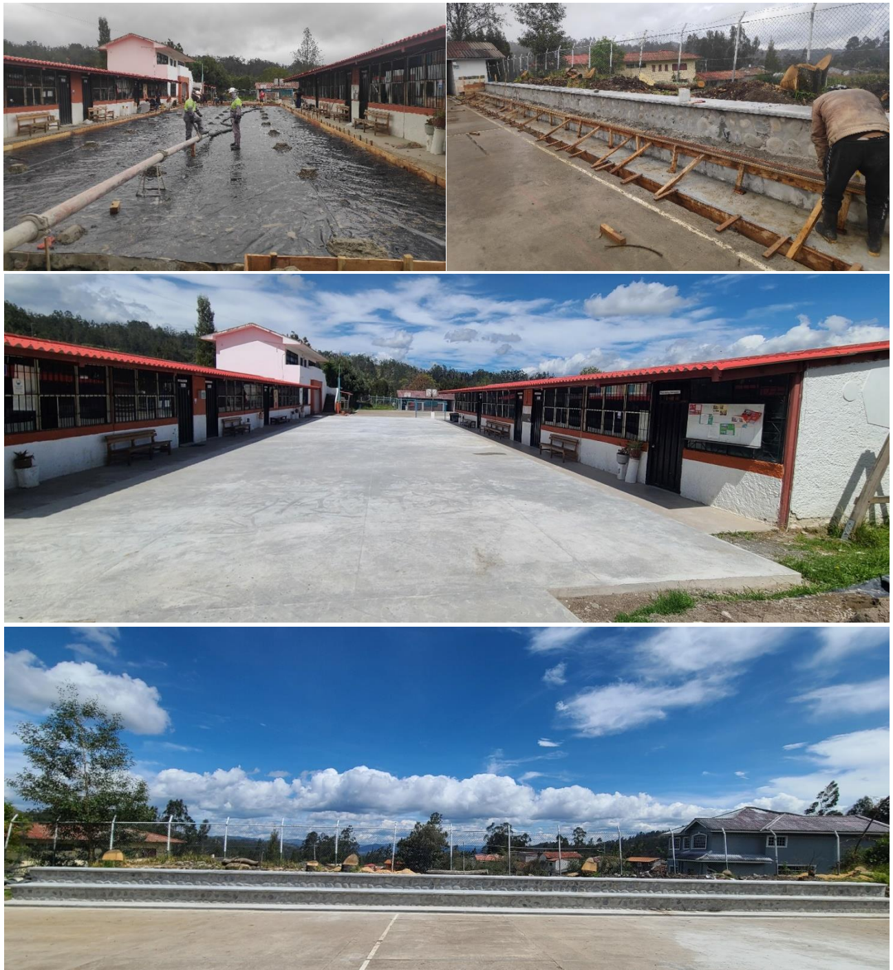
Foto 12: Mantenimiento de la Unidad Educativa Santa Rosa. Agosto 2023.
