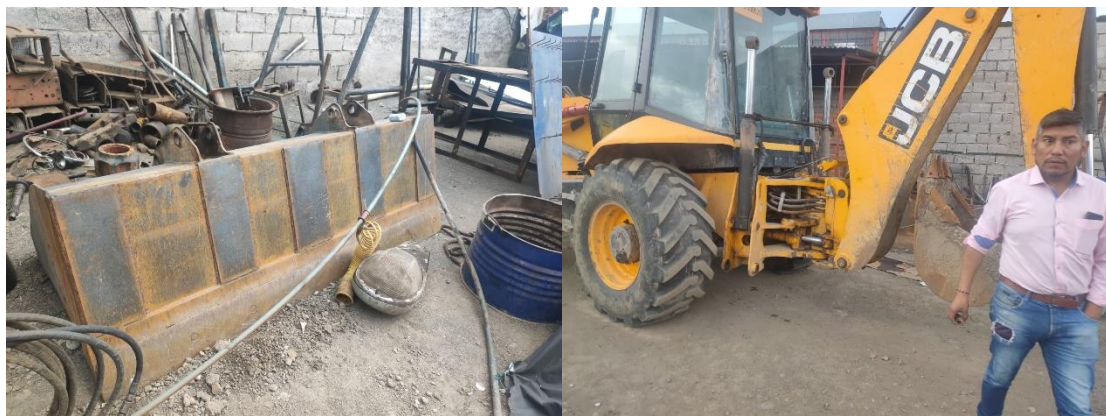
Foto 30: Mantenimiento correctivo y preventivo de la retroexcavadora. Diciembre 2023.
