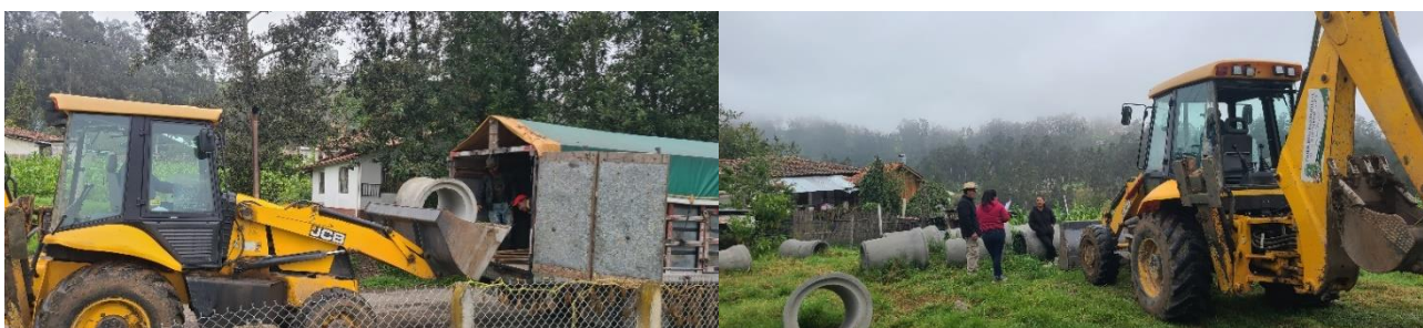
Foto 20: Entrega de tubos para pasos de agua
