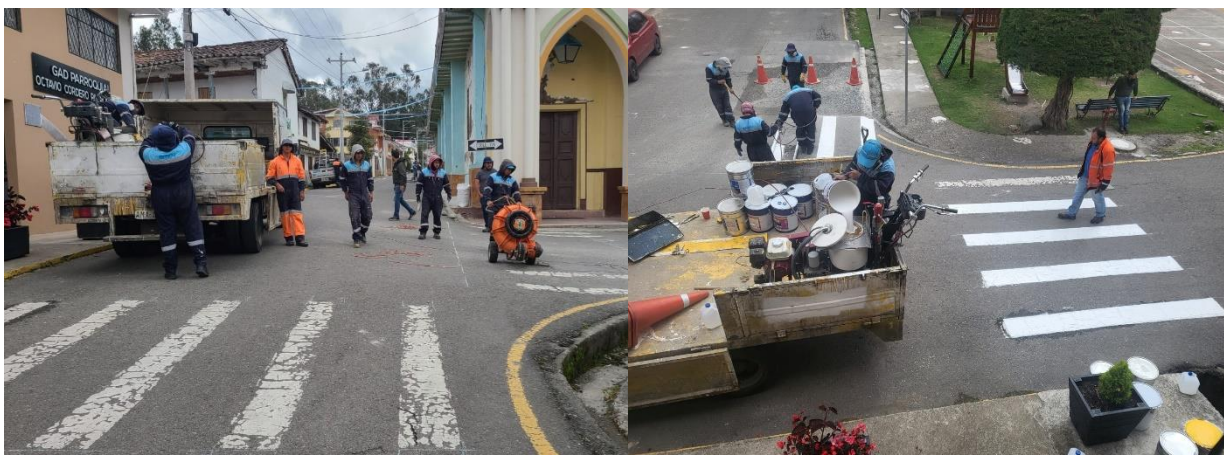
Foto 44: Pintado de señalización horizontal. Diciembre 2023.
