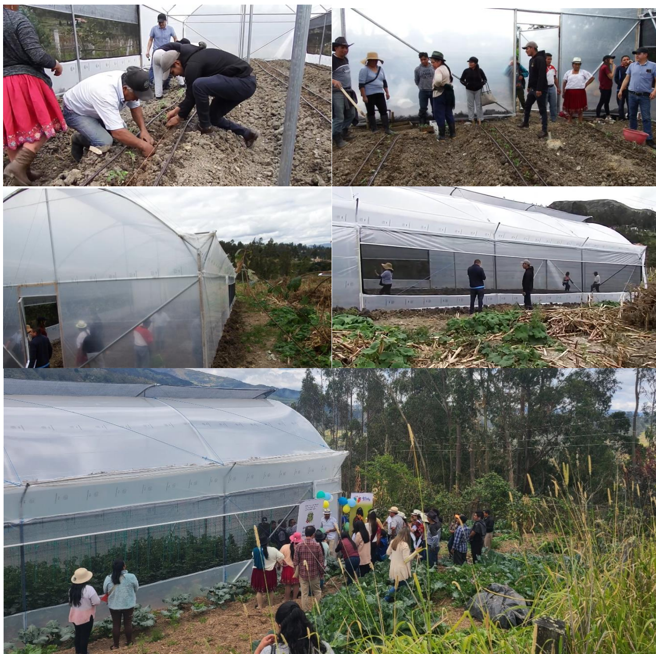
Foto 14: Construcción de invernaderos agrícolas en la parroquia Octavio Cordero Palacios. Agosto 2023.
