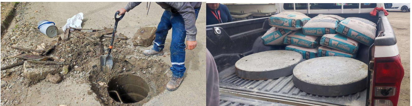
Foto 54: Reposición de tapas de alcantarillado
