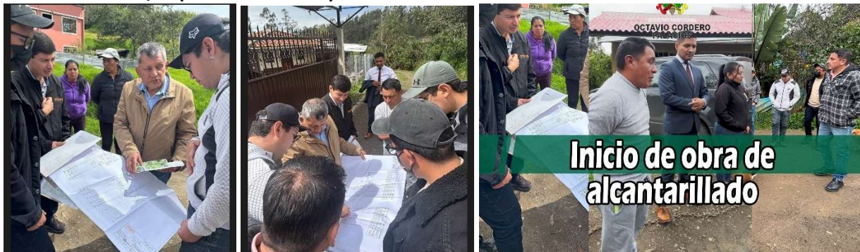
Foto 40: Inicio de obra de alcantarillado—sector El Cisne
