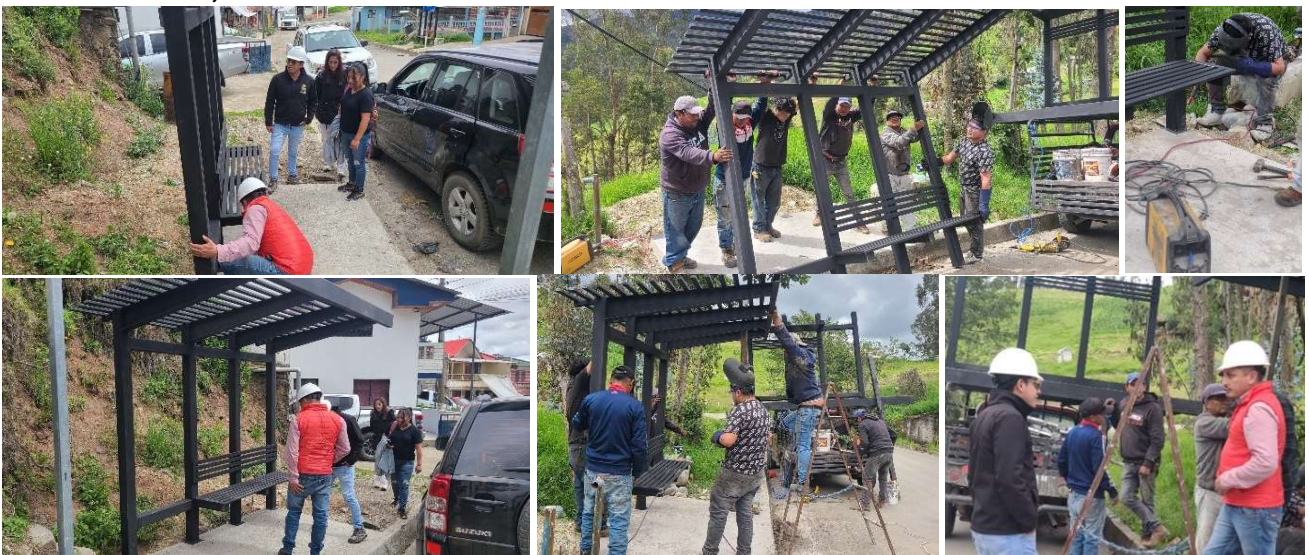
Foto 13: Construcción de paradas de buses (Segunda etapa)
