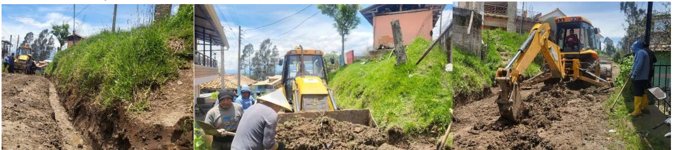
Foto 43: Minga de mantenimiento vial San Luis de Parcoloma
