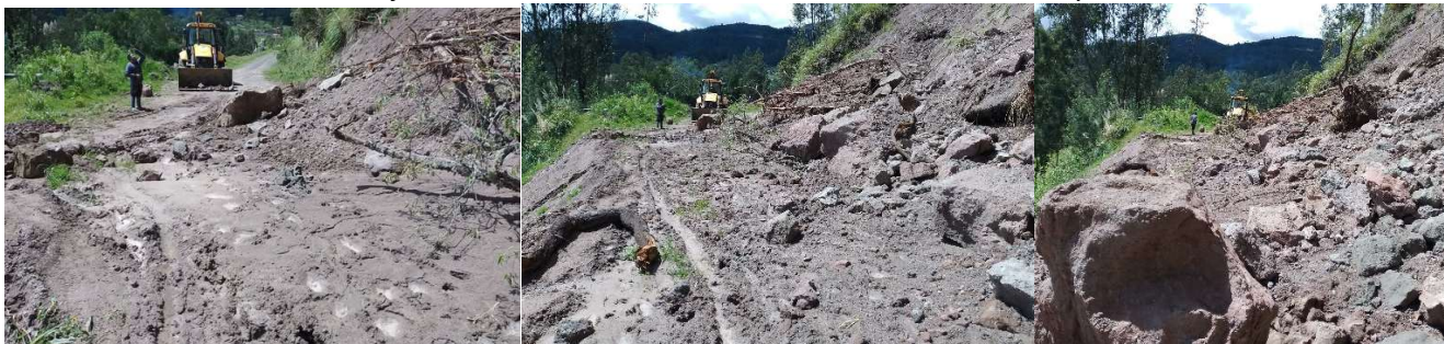
Foto 100: Trabajos de mantenimiento vial – Sector Haciendapamba
