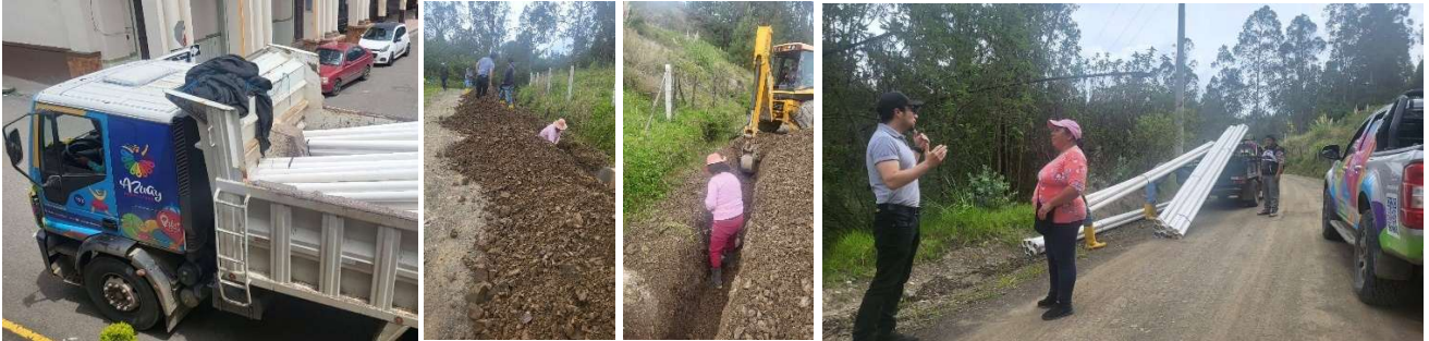
Foto 53: Mejoramiento del sistema de riego Adobepamba
