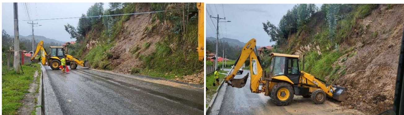
Foto 105: Trabajos Cristo del Consuelo - San Vicente
