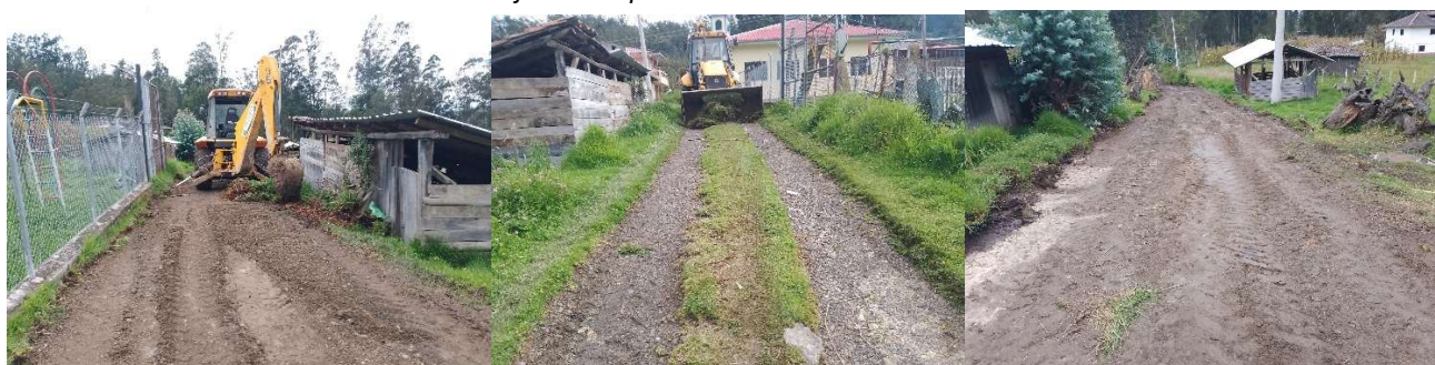
Foto 108: Trabajos de rehabilitación de vía - EL Calvario
