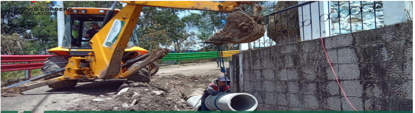
Foto 90: Colocación de pasos de agua sector La Gruta
