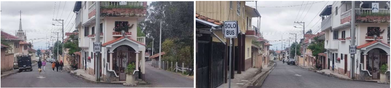
Foto 42: Instalación de señalética
