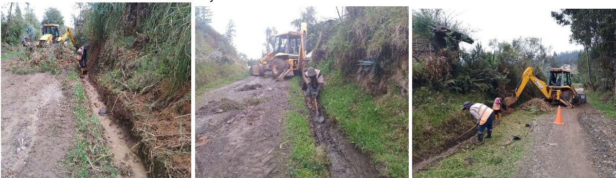
Foto 102: limpieza de cunetas y bacheo de la vía Urculoma
