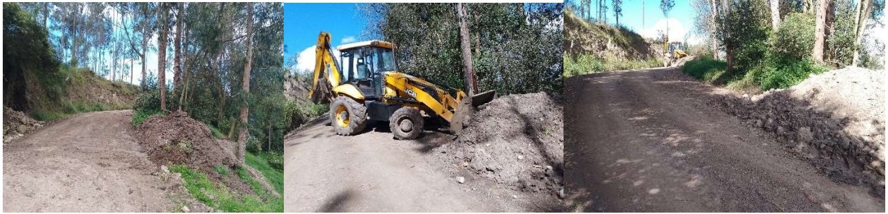
Foto 110: Trabajos de mantenimiento vial – Comunidad Azhapud
