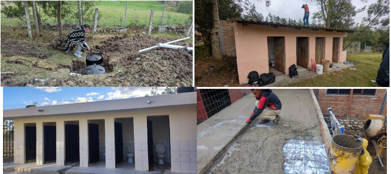
Foto 14: Readecuación de baterías sanitaria en comunidades
