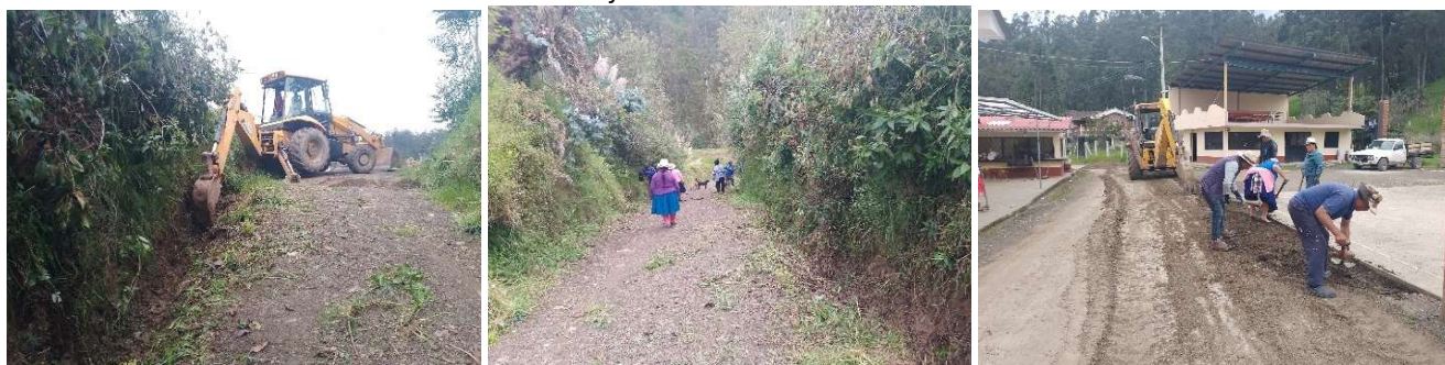
Foto 106: Trabajos de limpieza- Comunidad San Bartolome
