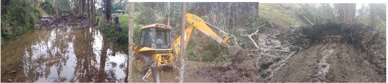
Foto 111: Trabajos de mantenimiento vial – Sector Illapamba
