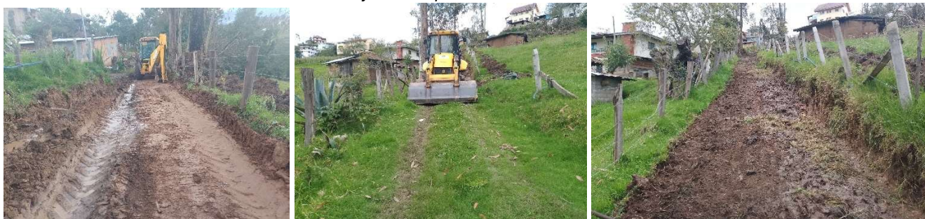
Foto 107: Trabajos de limpieza- Comunidad San Luis de Parcoloma
